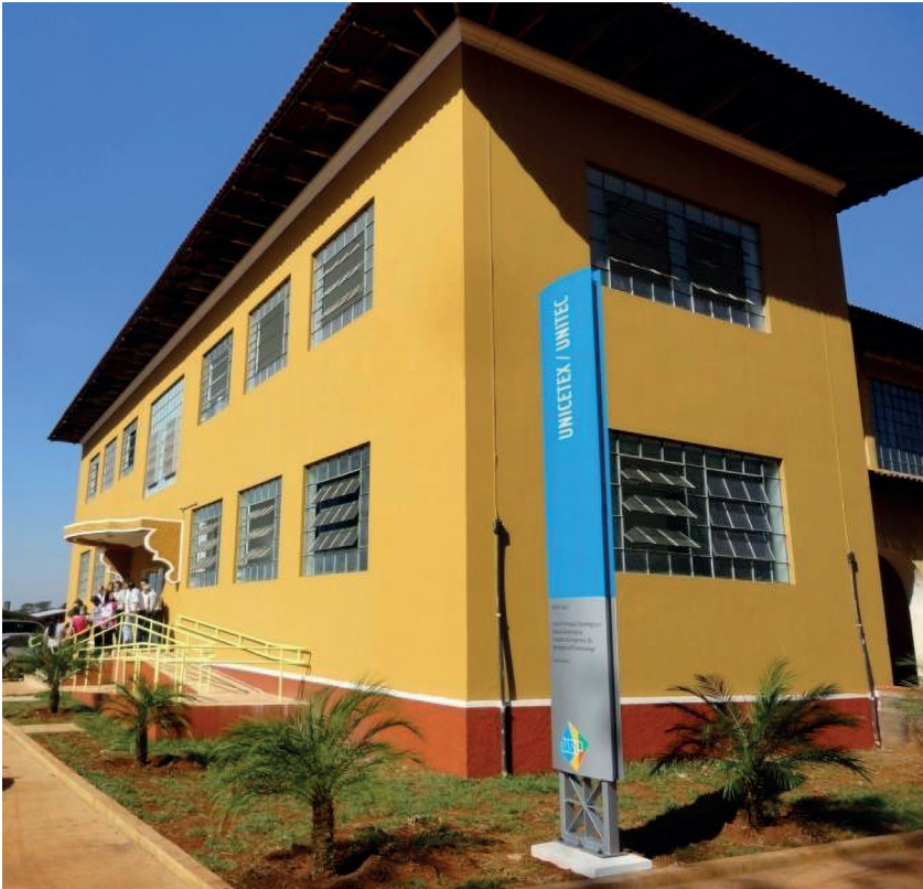
Foto: Vista actual del ala norte de UNICETec (ya en funcionamiento)
